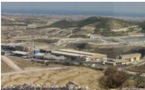
Μονάδα ΟΕΔΑ Λάρνακας - Αμμοχώστου
