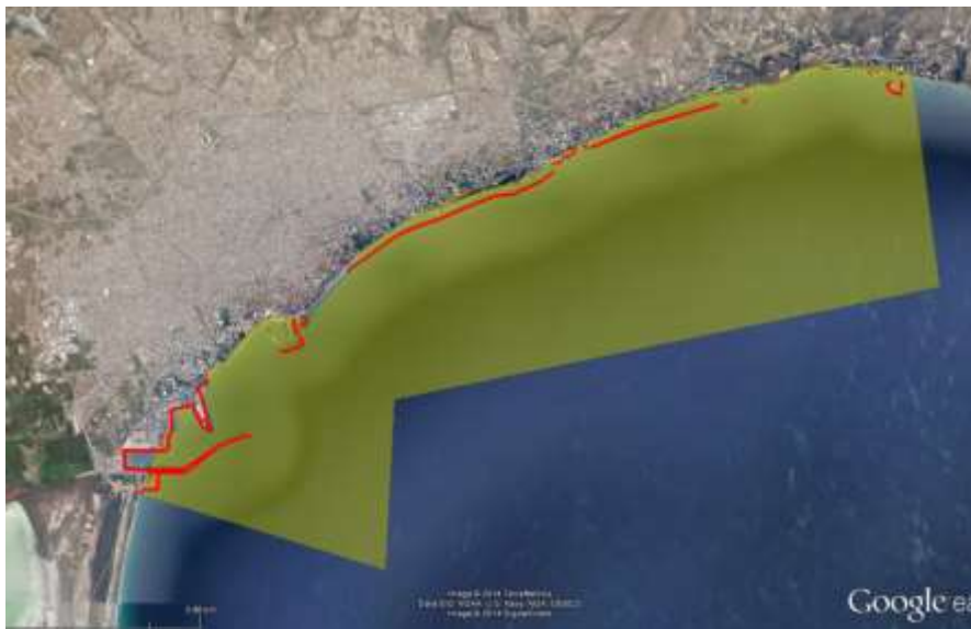
Εικόνα 11-4 Παράκτιο Σώμα Κόλπου Λεμεσού (CY_12-C2-HM). Το μεγαλύτερο μέρος της ακτογραμμής καλύπτεται από κυματοθραύστες και λιμενικά έργα
