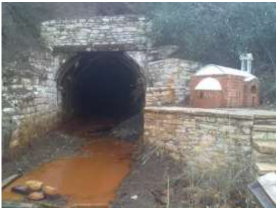
Απορροές από τη γαλαρία του Μεταλλείου Μούσουλος, ανάντη της Μ9 και κατάντη του ταμιευτήρα Καλαβασού 16
