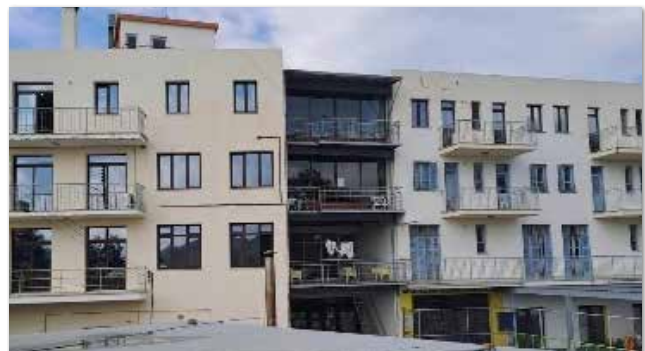
Εικόνες 4-6: Αποκατάσταση και συντήρηση Στέγης Ευγηρίας "Ελεούσα" στον Αγρό, ΟΤΔ «Αναπτυξιακή Εταιρεία Κοινοτήτων Περιοχής Τροόδους ΛΤΔ».
