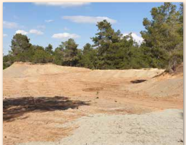
Διαμόρφωση και δένδροφύτευση του χώρου του νότιου μεταλλείου Μαθιάτη μετά την απομάκρυνση των χρυσοφόρων μπάζων για σκοπούς ανάκτησης του περιεχόμενου χρυσού στο μεταλλείο της Σκουριώτισσας
