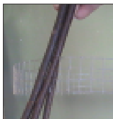
Τοποθέτηση ξύλινων κοτσανιών, εσωτερικά και εξωτερικά πάνω στο συρμάτινο πλέγμα
