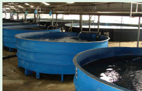
Δεξαμενές εξωτερικού χώρου
