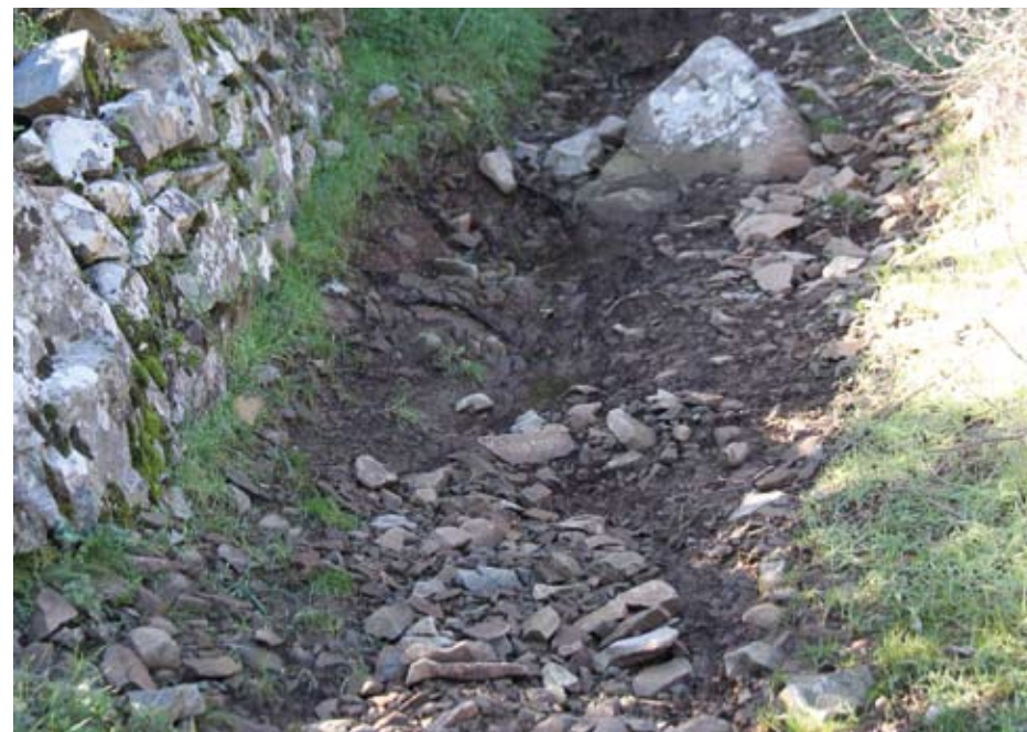
Εικ.21: Απαράδεκτη διάβρωση λόγω κακού σχεδιασμού
