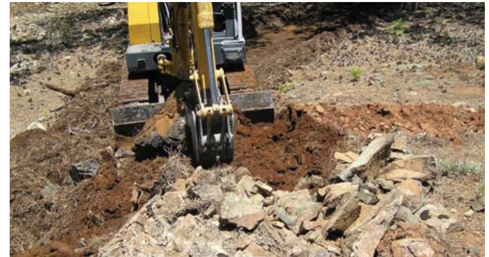
Εικ.4: Διάνοιξη μονοπατιού με mini digger
