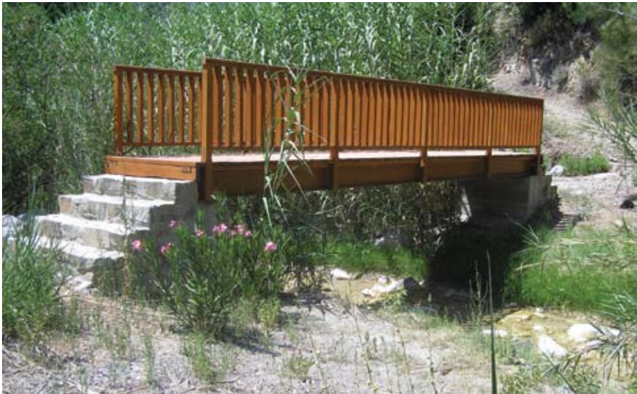
Εικ. 14: Τύπος γεφυριού με πέτρινα σκαλιά και ξύλινο κατάστρωμα
