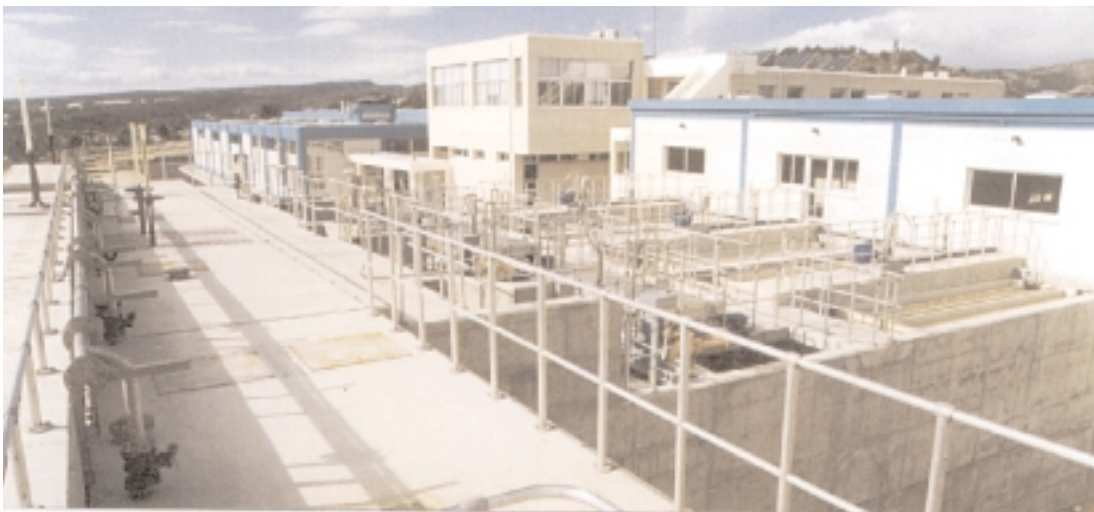
Γενική άποψη του διυλιστηρίου νερού Λεμεσού
