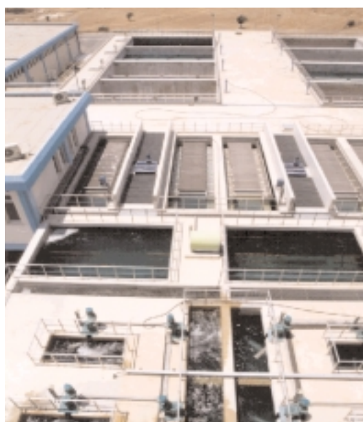
Δεξαμενές κροκίδωσης, καθίζησης και φίλτρων
