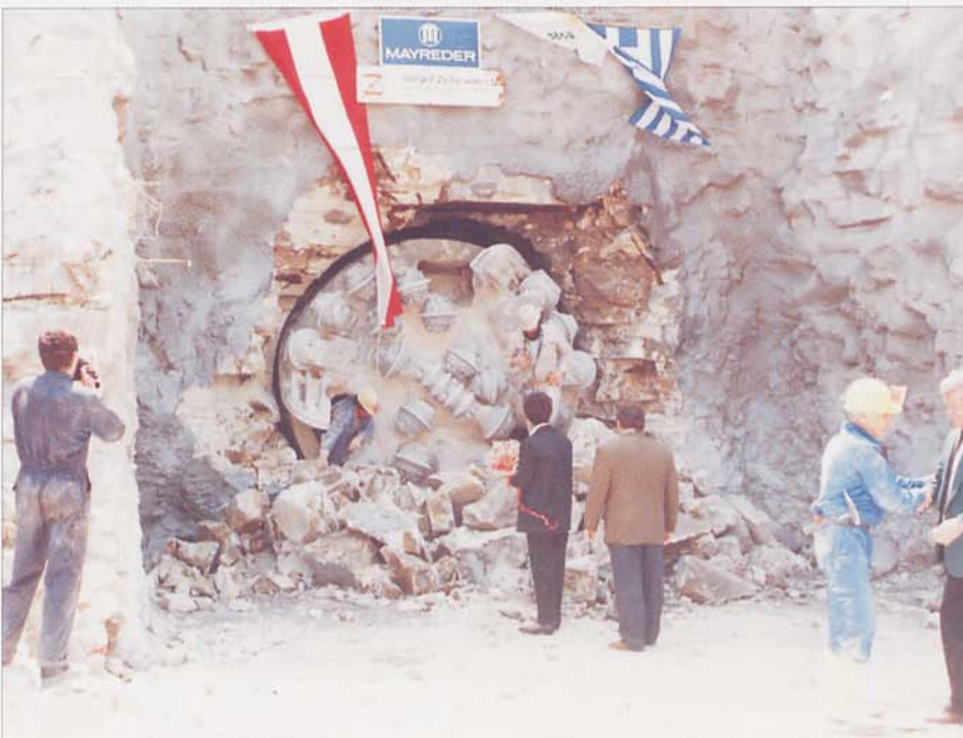
Σήραγγα εκτροπής Διάριζου - Dhiarizos diversion tunnel
