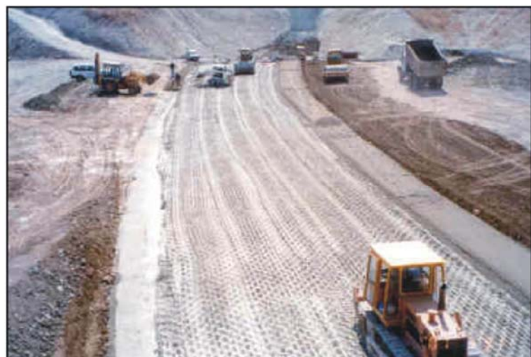
Κατασκευή αναχώματος - Embankment under construction
