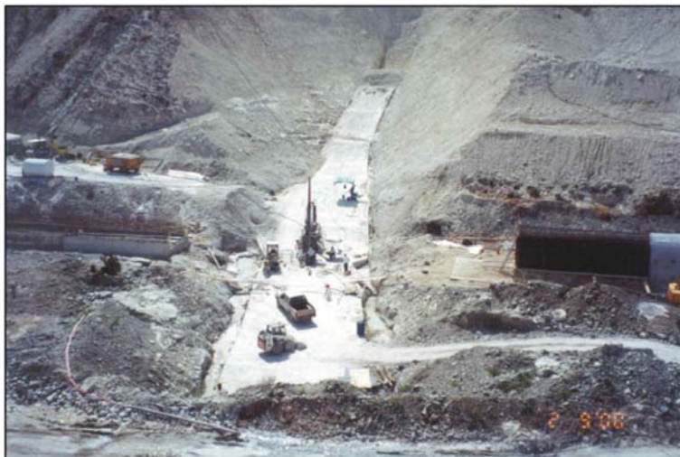
Γενική άποψη θεμελίων του φράγματος - General view of dam foundations
