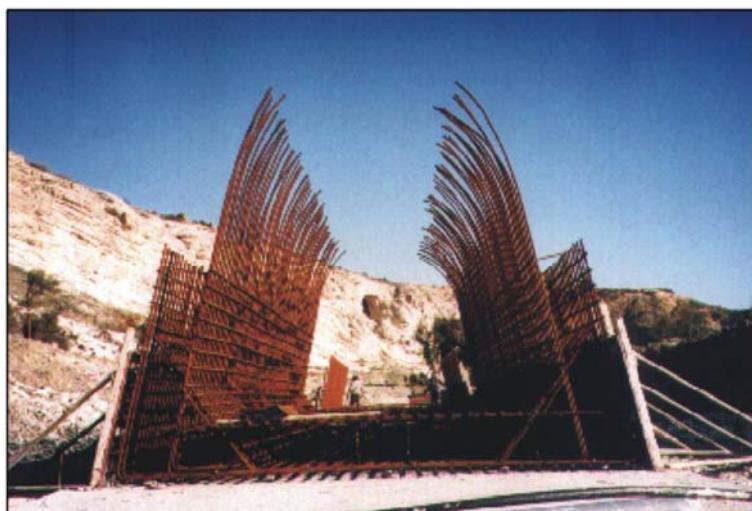
Κατασκευή έργων υδροληψίας - Draw-off culvert under construction
