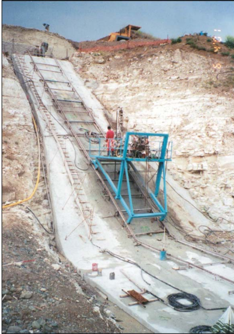
Τσιμεντέσεις στο δεξιό αντίκρουσμα - Grouting of right abutment
