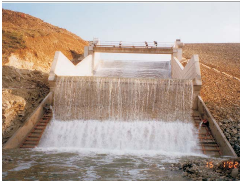
Υπερχείλιση του φράγματος - Overspilling of dam
