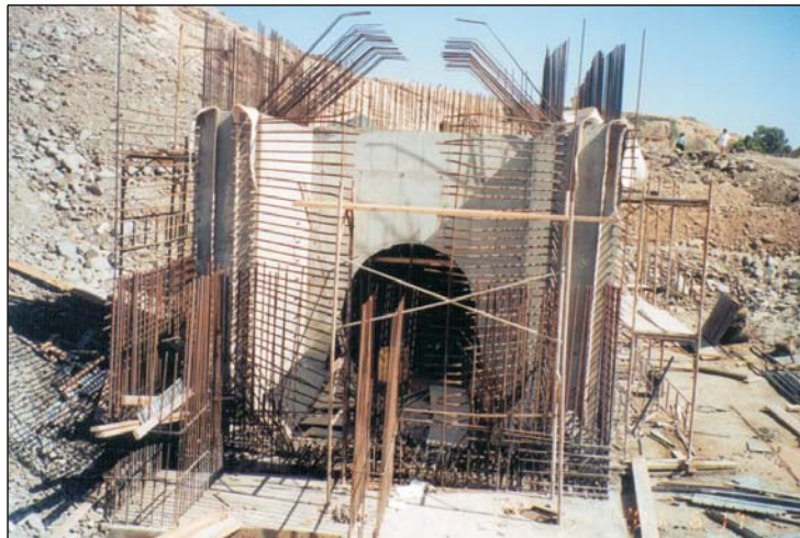
Κατασκευή έργων υδροληψίας - Intake structure under construction
