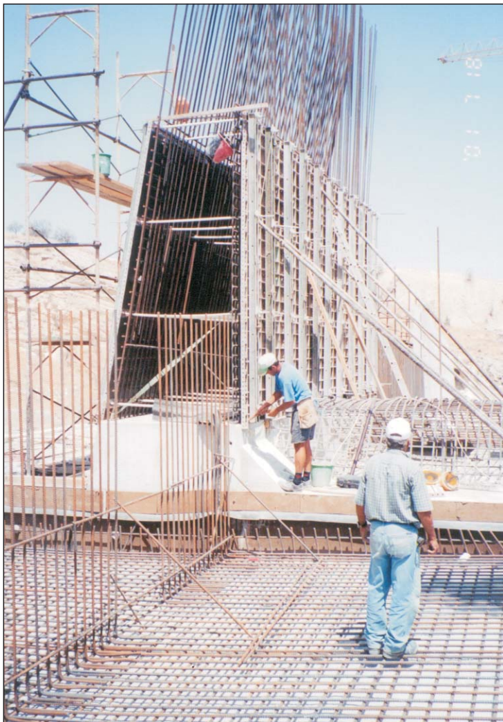
Υπερχειλιστής υπό κατασκευή - Spillway under construction
