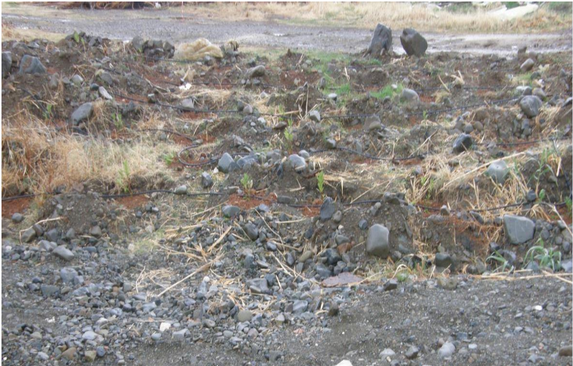
Εικόνα 26: Σε σημεία όπου η μορφολογία του εδάφους και το πλάτος της όχθης το επέτρεπαν έγιναν φυτεύσεις σε όλο το πλάτος της όχθης, με παράλληλες σειρές φυτεύσεων.
