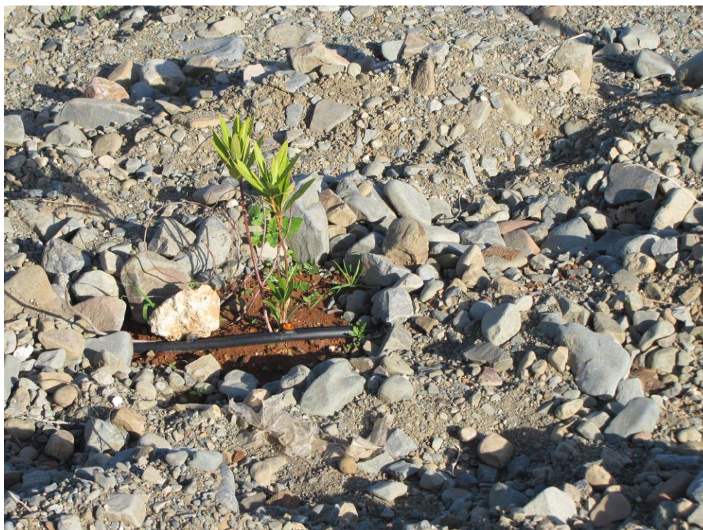
Εικόνα 30: Λεπτομέρεια του συστήματος άρδευσης και της τελικής του διαμόρφωσης, με την κάλυψη των λάστιχων για την προστασία τους και την αισθητική βελτίωση του χώρου.
