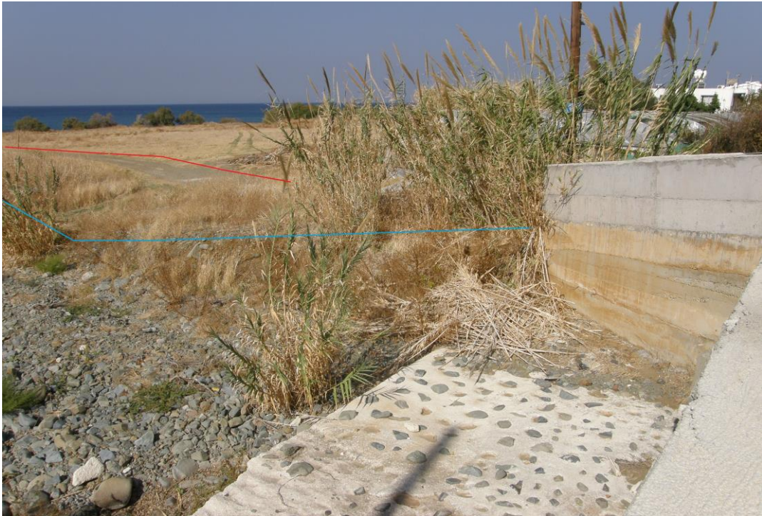
Εικόνα 3: Χαρακτηριστική φωτογραφία της δεξιάς όχθης του ποταμού, προς την εκβολή, όπου απεικονίζεται η σημερινή κοίτη, σε σχέση με την εγγεγραμμένη κοίτη ποταμού από την οποία σήμερα διέρχεται αγροτικός δρόμος. Με γαλάζιο χρώμα σημειώνεται η υφιστάμενη κοίτη και με κόκκινο χρώμα η οριοθετημένη δημόσια κοίτη.
