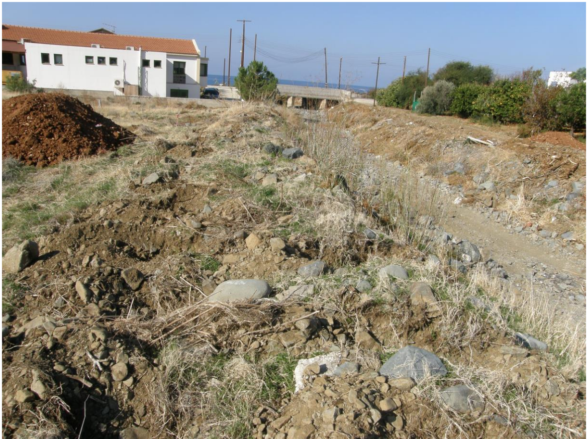
Εικόνα 20: Η εκσκαφή λάκκων φύτευσης πραγματοποιήθηκε στα σημεία που είχαν προηγουμένως σημανθεί. Παράλληλα έγινε μεταφορά χώματος για χρήση κατά τις φυτεύσεις των δενδρυλλίων.
