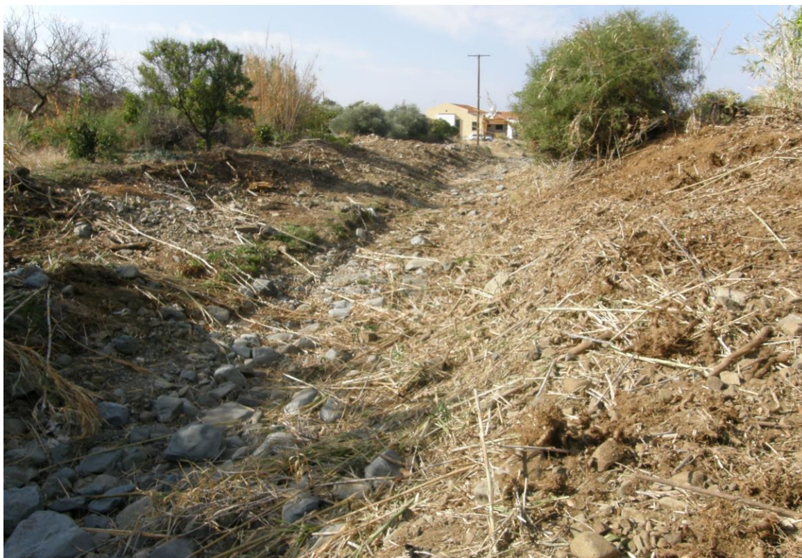
Εικόνα 16: Διαμόρφωση της όχθης με τη δημιουργία ανομοιόμορφης μορφολογίας και διαφορετικά επίπεδα
