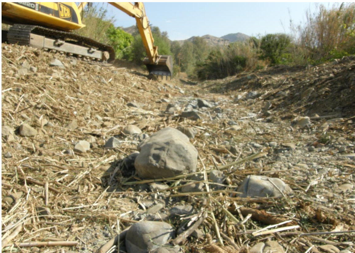
Εικόνα 17: Τοποθέτηση μεγάλων ογκόλιθων εντός της κοίτης για την αύξηση της ποικιλότητας ενδιαιτημάτων.
