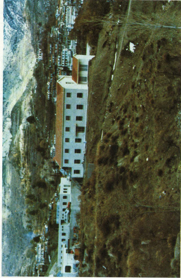
Κτιριακό συγκρότημα στον Αγρό (Γραφεία και ΚΕΓΕ). Agros building compound (Offices and Farmers' Training Centre).
