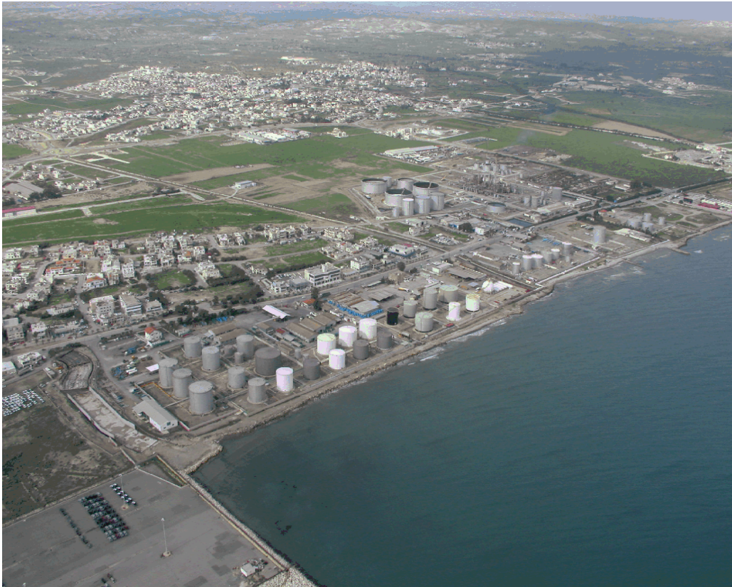
Εικόνα 6.1.4-1 Κυπριακό Διυλιστήριο Πετρελαίου Λτδ και Αποθηκευτικοί Χώροι Εταιρειών Εμπορίας Πετρελαιοειδών [31]
