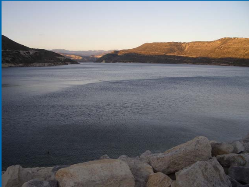
06/03/2004 – Φράγμα Κούρη (Υπερχείλιση)
