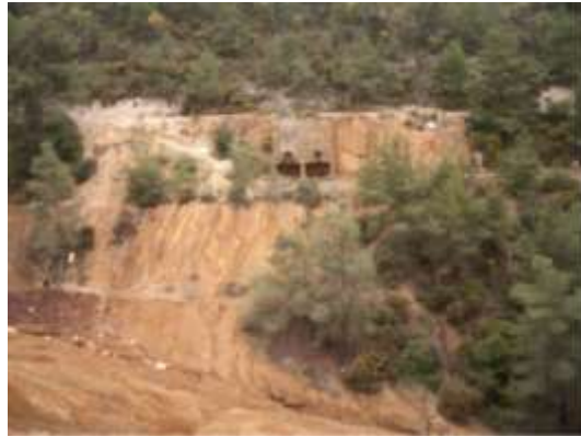
ΕΕΑ M18 - Σωρός Αποβλήτων Μεταλλείου Κινούσας (υπόγειο) στον χώρο φόρτωσης του μεταλλεύματος – Απορροές προς Φράγμα Αργάκας [33]
