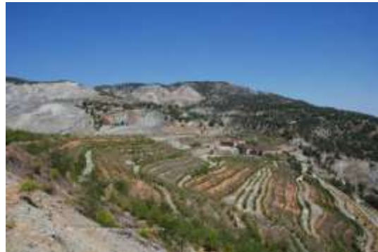
Εργασίες αποκατάστασης/αναδάσωσης μεταλλείου 20
