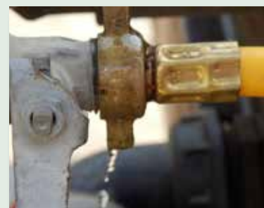
Διαρροή σε σημείο συνδεσμολογίας
