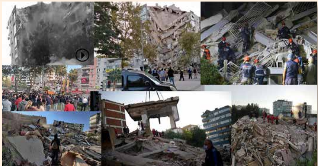
Σχήμα 4: Δομικές ζημιές στη Σμύρνη (Τουρκία) λόγω του σεισμού της 30 ης Οκτωβρίου 2020 (από διάφορες πηγές στο διαδίκτυο).
