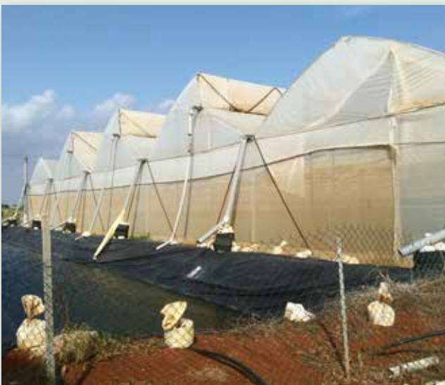
Δεξαμενή και σύστημα συλλογής νερού από την οροφή θερμοκηπίου
