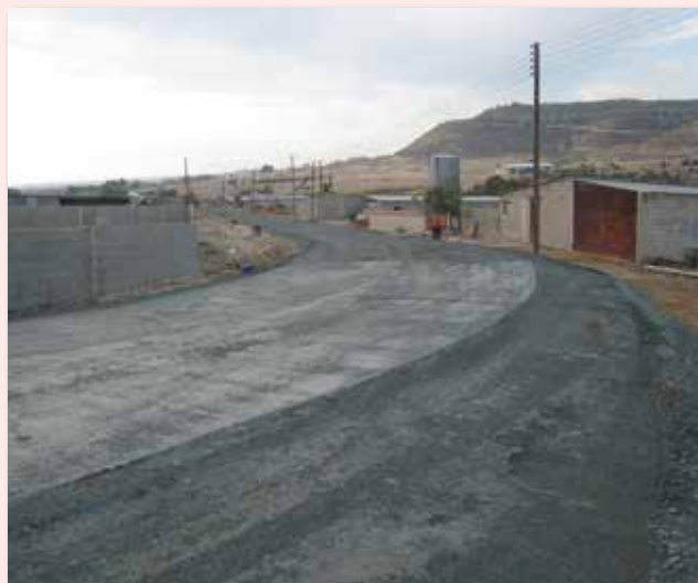
Ηλεκτροδότηση και επίστρωση με χαβαροτσιάκκιλο δρόμου της Κτηνοτροφικής Περιοχής Ορόκλινης
