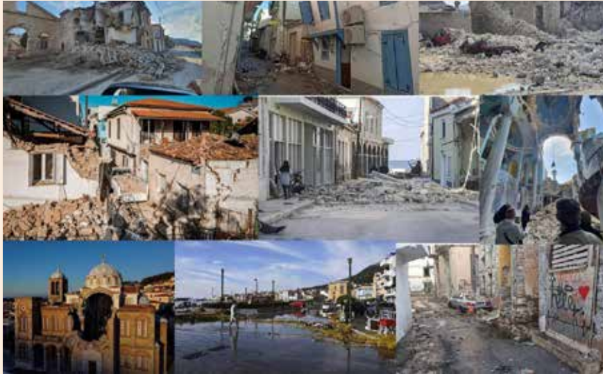
Σχήμα 3: Δομικές ζημιές στη Σάμο (Ελλάδα) λόγω του σεισμού της 30 ης Οκτωβρίου 2020 (από διάφορες πηγές στο διαδίκτυο).
