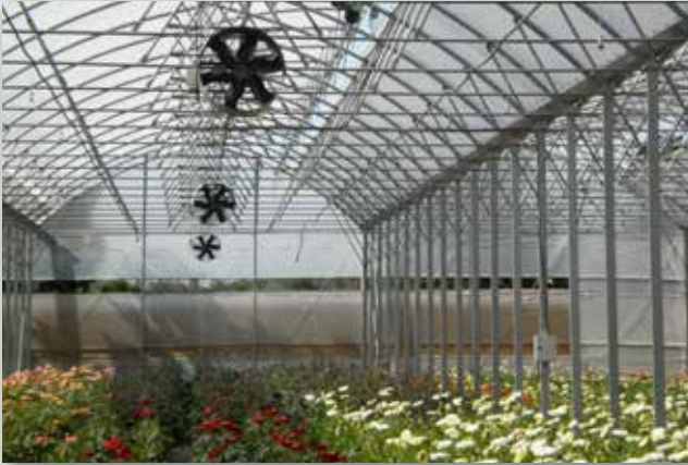
Κυκλοφορητές αέρα σε θερμοκήπια
