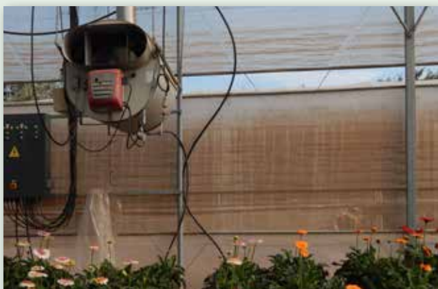
Αερόθερμο σε θερμοκήπιο
