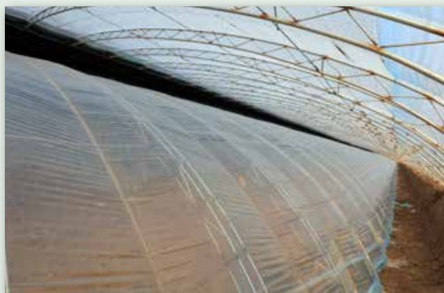
Σύστημα διπλού πλαστικού κάλυψης θερμοκηπίου
